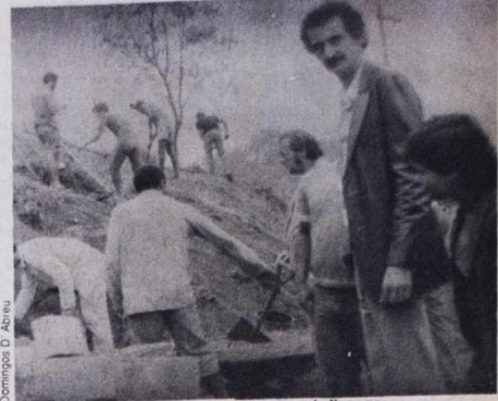
Luizão, à direita, acompanha os trabalhos de limpeza
