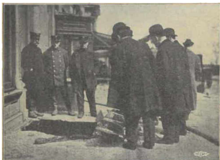
RUUMIIT PUTOILIVAT LÄPI KATUKÄYTÄVÄN
