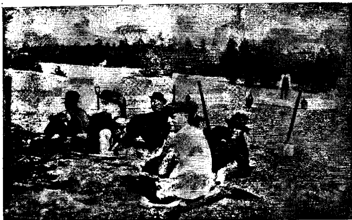
Haudankaivajia Santahaminassa kesällä 1918.
